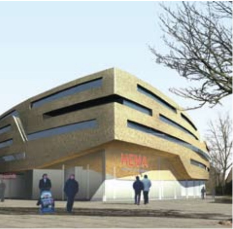
Dagbestedingsruimte met rieten gevelbekleding en gezeefdrukt glas waardoor het gebouw zich op vanzelfsprekende wijze invoegt in het Delftse Hout.
