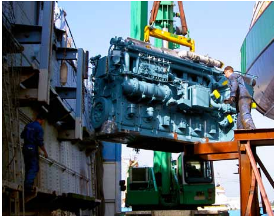
Het vervangen van de motor.
